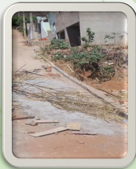
Operação Tapa Buracos na Rua Vicente Baldoino no Bairro Bomba
