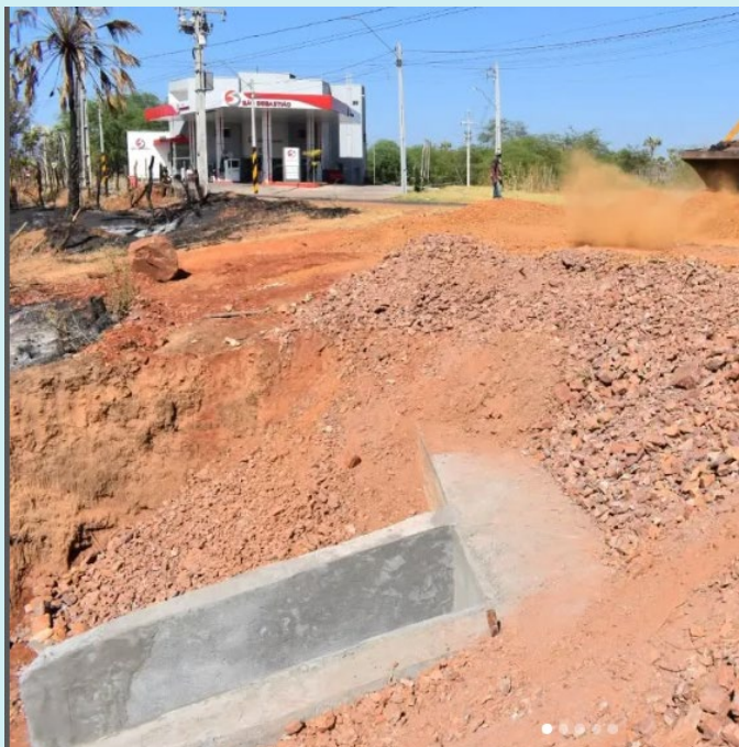
Construção da galeria da Av. Severo Eulálio
